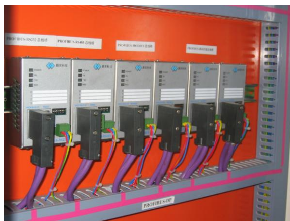
图 3-8 连接 PROFIBUS 设备的标准 PROFIBUS 插头
